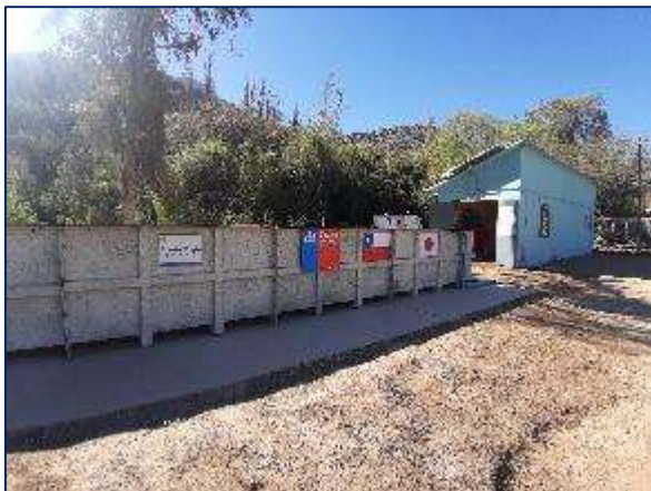
Comuna de Río Hurtado Planta de tratamiento de aguas residuales a pequeña escala con tecnología japonesa
