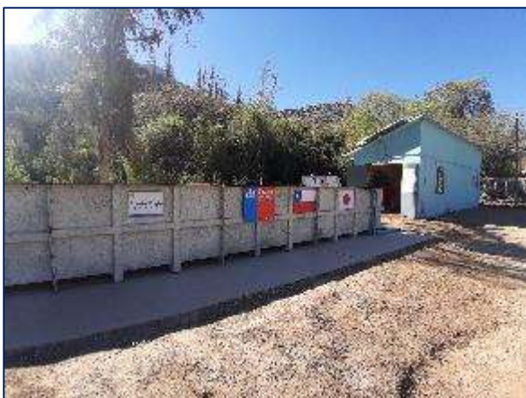
リオ・ウルタド市 日本の技術を導入した小規模下水処理施設
